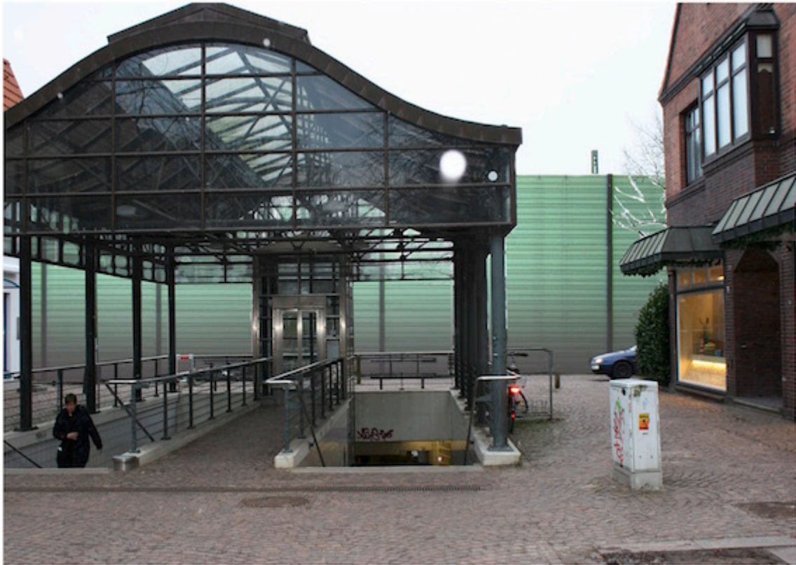
Neue Lärmschutzwände entlang der zukünftig ausgebauten Bahnstrecke auf Ahrensburger Stadtgebiet: Die Stadtverwaltung hat digitale Vorschauen gefertigt. Im Bild der Bereich in der Manhagener Allee.
